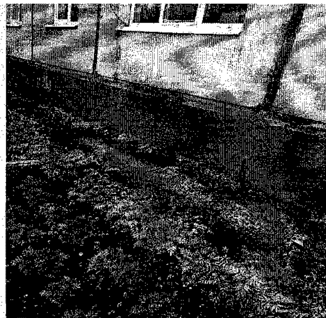
Фото 1,2. Разрушение отмостки по периметру здания. Наличие трещин и локальных разрушений окрасочного и штукатурного слоя стен цокольного этажа.
