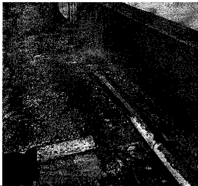
Фото 1,2. Разрушение отмостки по периметру здания. Наличие трещин и локальных разрушений окрасочного и штукатурного слоя стен цокольного этажа.
